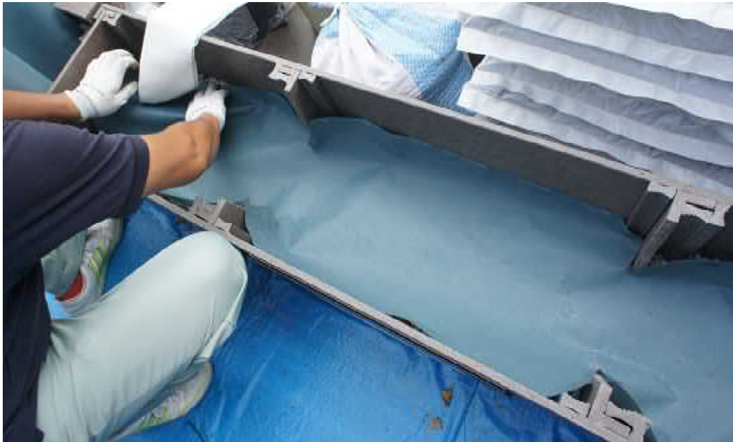
くるくるストップシートをリブラ f システムコンテナに敷設 側面まで敷く方が根の老化防止には効果大
