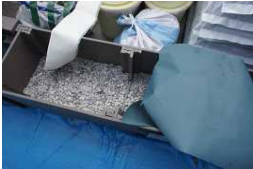
パーライトの上にくるくるストップシートを敷く
