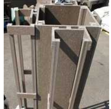
外柱を四面にはめ込む
