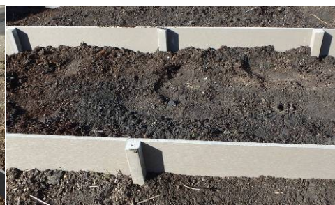
土留め仕上り
