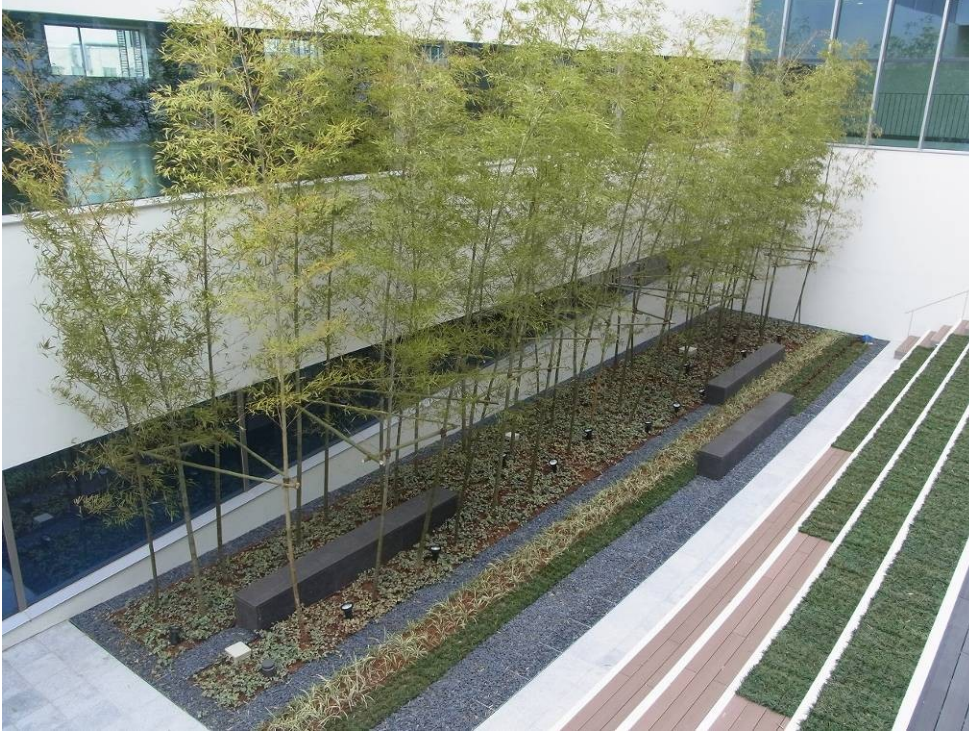
砂利と植込みの見切り (4 mm) と竹のルートバリア (12 mm) の使用例
