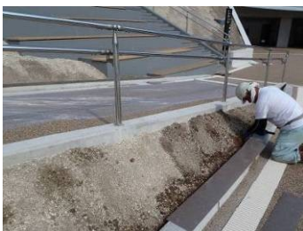
舗装に接して隙間穴を作る
