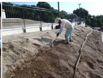
穴を掘ってエッジを入れる
