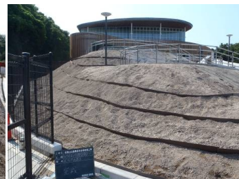
エッジ入れ完了
