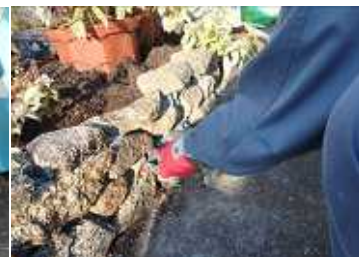
隙間に合った擬岩をはめ込み
