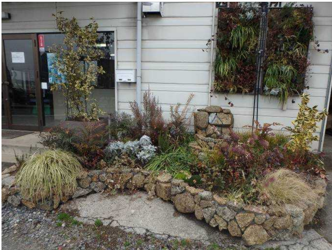
リブラ曲面立上げ壁 擬岩貼り付け
