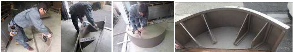
曲面板に補強板をビス止め
