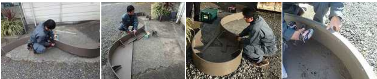
曲面リプラボード現場に設置
