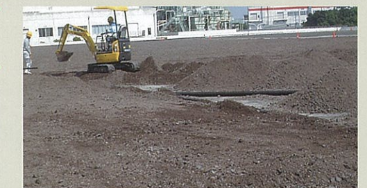
▲下水処理場覆蓋緑化工事で施工された排水材。カルグリを排水材として使用しています。
