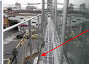
施工前 設置位置
