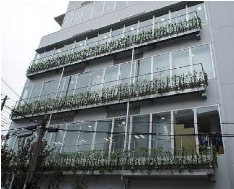
大阪市内某ビル 壁面緑化 L1.8mxW18cmxH34cm コンテナを連結 全長約 14m
