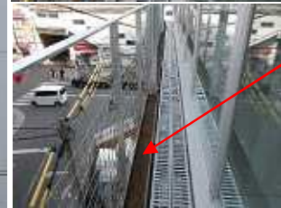
設置完了 設置位置
