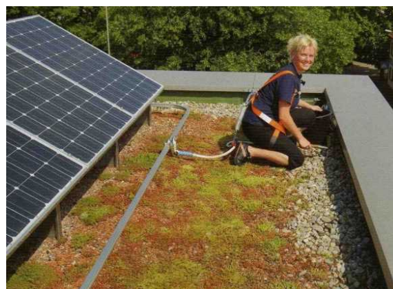
・ソーラーパネルと屋上緑化:植物が温度上昇を抑え発電効率を高めている。また、立上り際までのメンテナンスに備え、安全対策も講じている。
