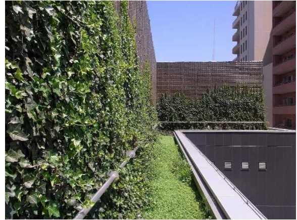
・屋上緑化とヤシマット併用金網補助使用した壁面緑化（イワダレソウまたはタマリユウとヘデラ）
