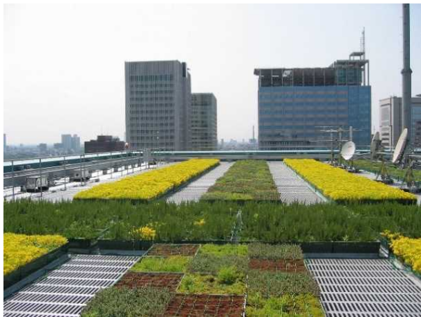
・ヘリポートのFRPコンテナを使用したセダム緑化 植栽基盤厚100で無灌水。
