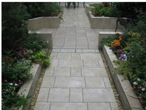
・コンクリートブロック積みにタイル張り仕上げ
