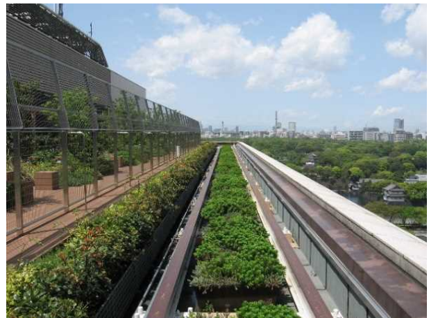
・ゴンドラレールのコンテナを使用したセダム緑化 植栽基盤厚100で無灌水。
