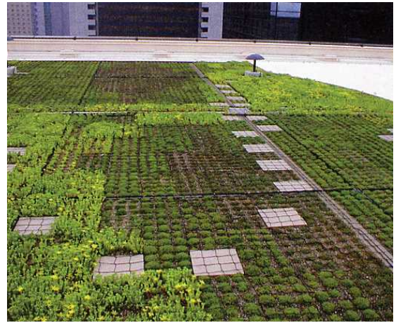
・飛散防止用のネットとSUSワイヤーの設置
