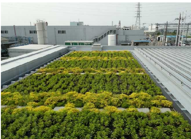
・雨水貯留型パレットを使用した折板屋根のセダム緑化。 雨水センサー付きの自動灌水で灌水。
