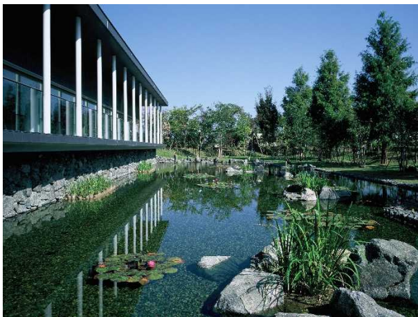
・池底は砂利敷で護岸は蛇籠を使用して調整池機能のあるレインビオトープ（2016 年ビオトープ大賞受賞）
