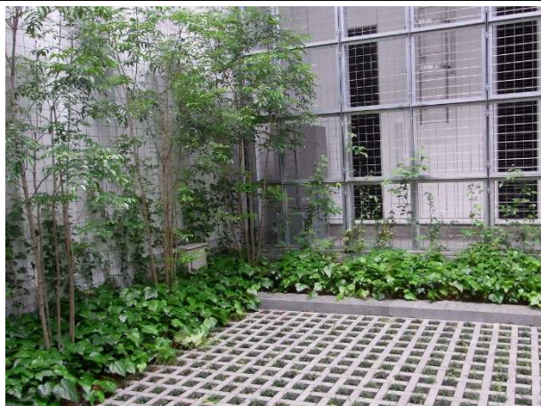
・タマリユウのコンクリートブロック製の透水性芝生舗 装にした緊急用の駐車場。グリーンパーキング
