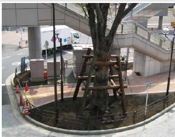
・移植のケヤキの大木と井桁支柱
