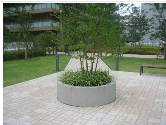
・基礎不要の TLC を使用して基盤を高くし、根腐れと踏圧防止図るとともに地被を植栽して改修
