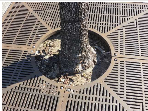
・地下支柱の食い込みによる枯れ
