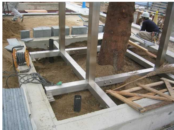
・角パイプ支柱
