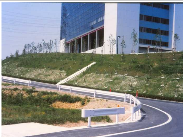
・1mの苗木植栽に法面緑化
