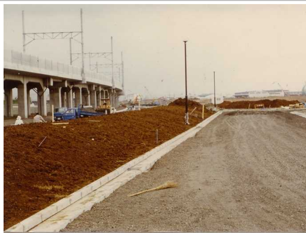
・植栽基盤の盛土造成(海岸埋立地)
