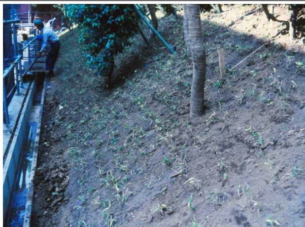
・30度の勾配での法面植栽
