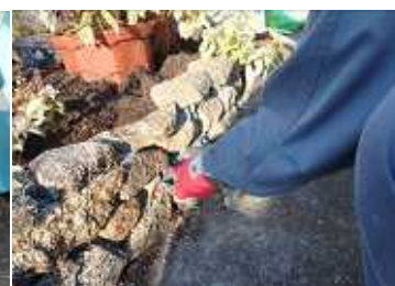
隙間に合った擬岩をはめ込み
