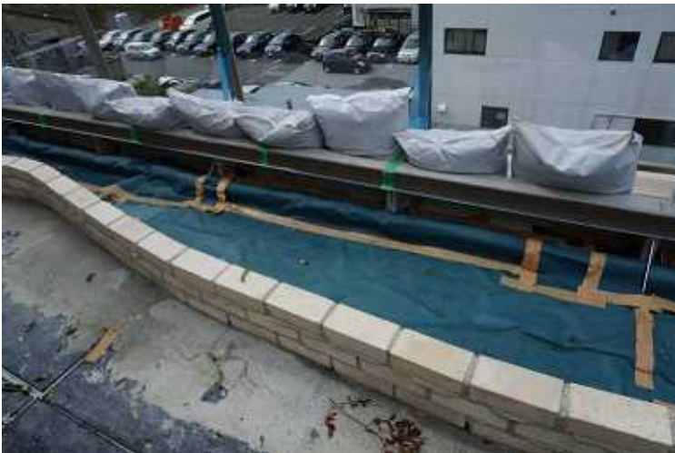
岐阜屋上緑化花壇に、くるストシートを敷設
