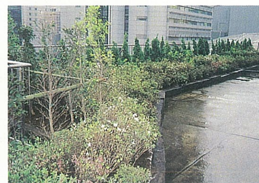
▲地下鉄駅ビル屋上
