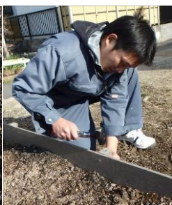
リフraf杭打ち込み
