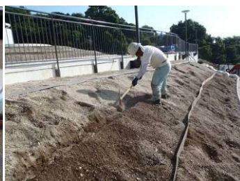
穴を掘ってエッジを入れる
