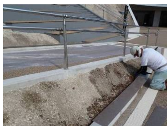
舗装に接して隙間穴を作る
