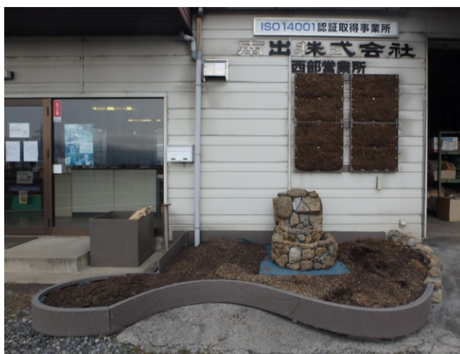
曲面リフラ枠に 擬岩貼り付け
