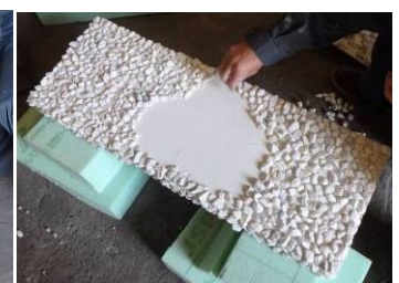
中ジャリ石は貼り付ける コテで仕上げし、一日放置する
