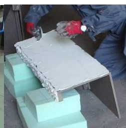
リフラ板にボンドを塗る
